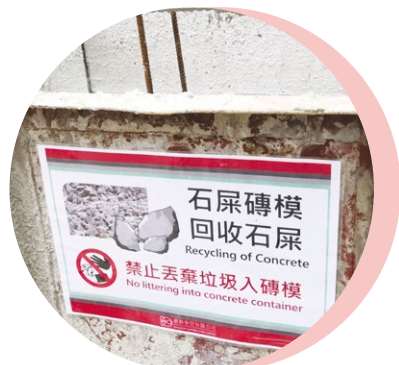
收集混凝土以進行回收
