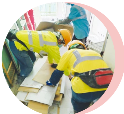
工人於工地篩選及分類建築廢物
