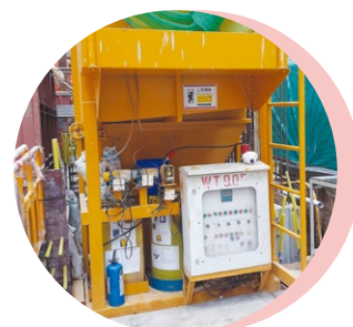
工地設置的污水重用系統
