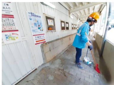
保持工地四周的環境衛生
