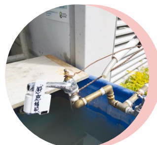
工地裝設配有觸動傳感器的水龍頭
